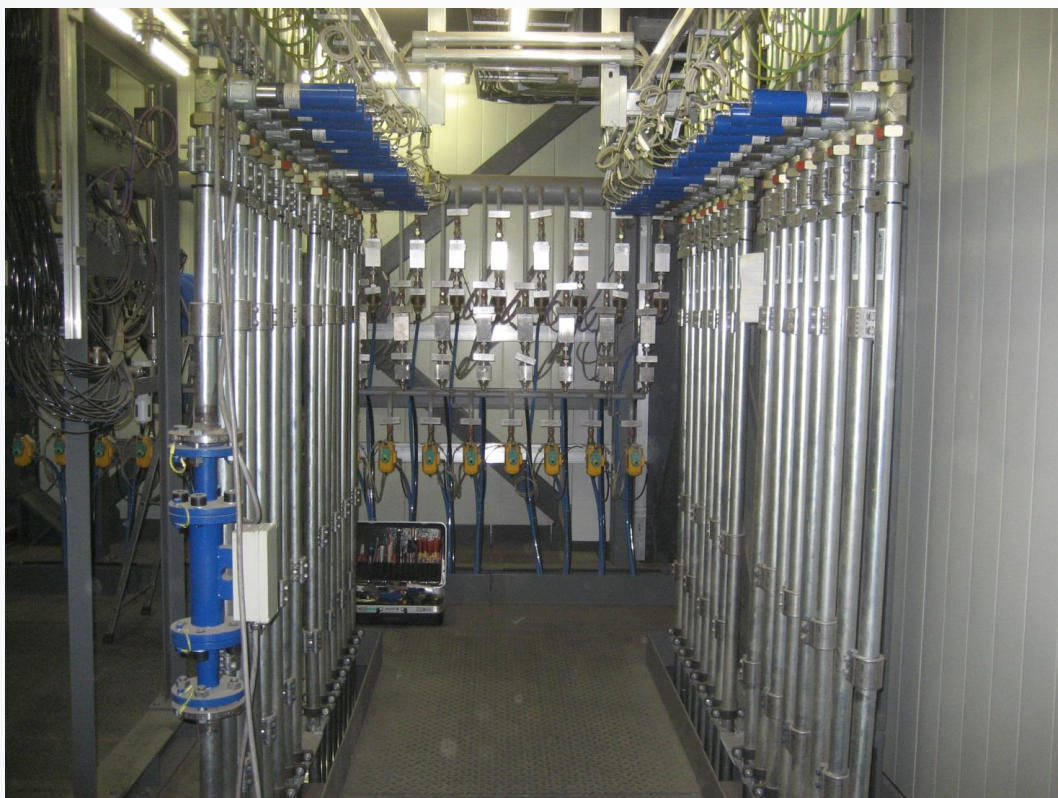
Detecção de injeção de carvão pulverizado em plantas de PCI
